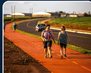
Pavimentação prolongamento da Av. Rouxinol.
