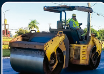
Recursos para Pavimentação Asfáltica Rua Guaratinga.
