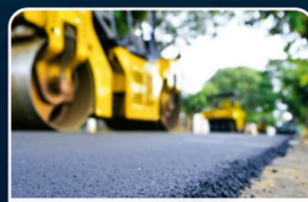
Recuperação da malha asfáltica de várias ruas no Conjunto Flamingos.
