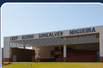
Gestão para instalação da Escola Técnica Ozório Gonçalves Nogueira: R$ 8.500.000,00
