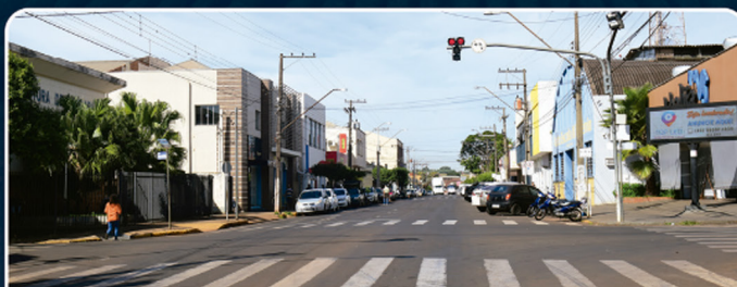
Obras de Pavimentação e Drenagem em Ruas Centrais: R$ 460.952,38
